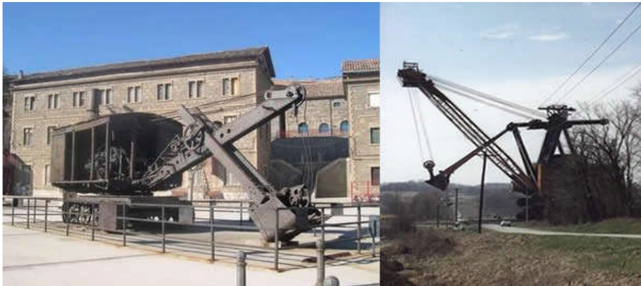
FIGURA 1-4: Excavadora de Vapor Bucyrus
