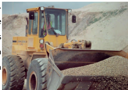
FIGURA 3-3:Excavadora o pala cargadora con ruedas
