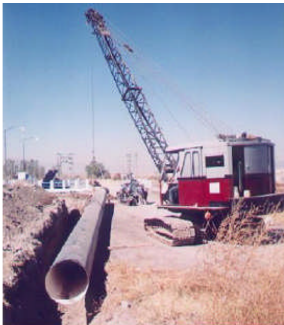
FIGURA 5-4: Construcción de oleoductos
