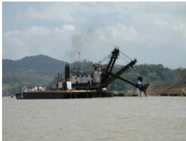
FIGURA 5-5: Dragas con tolva operando en la profundización de el Canal de Panamá
