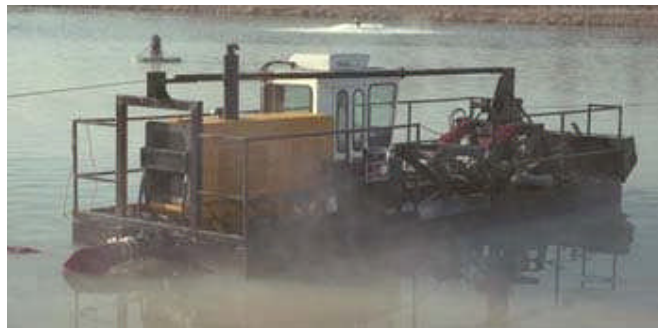
FIGURA 5-7: Dragado y Bombeo en Bajas Profundidades
