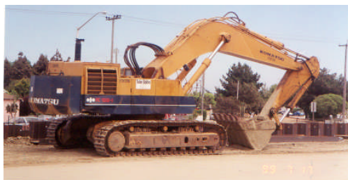
FIGURA 4-3:Retroexcavadora sobre oruga
